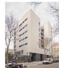
Habitatges de protecció oficial al carrer Comte Borrell 159 de Barcelona (IM-IAB - Ajuntament de Barcelona).
